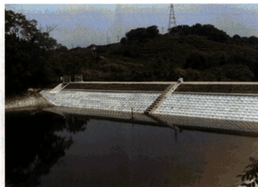
清水上地区ため池等整備事業(本郷町) (平成21年度事業完了)
