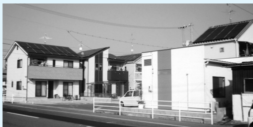
住宅用太陽光発電システム
