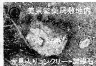
両備福山駅を出ると約300m北上し、高野山別院の南側を踏切で越え、美泉堂薬局③から右に急カーブ(半径100m)した。この急カーブの荷重を支えるため線路下に礎石④が置かれた。
